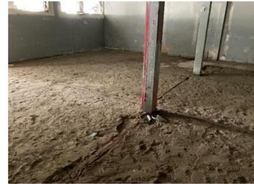
Zone de sol désamiantée au sous sol
