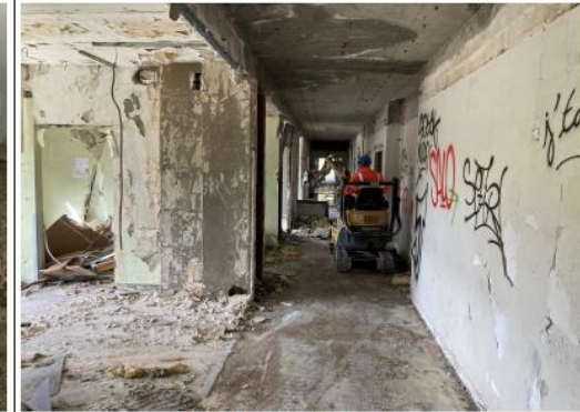
Curage mécanique en cours RDC
